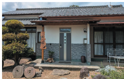
改修後の施設玄関回り(番号キー導入)
