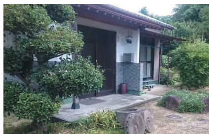
改修前の施設玄関回り
