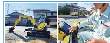
「土木現場の効率化」でカメラ搭載したショベル(左)とタブレットでの確認状況(右)
