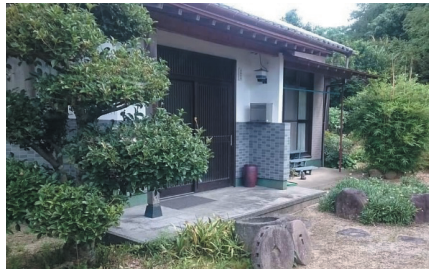
改修前の施設玄関回り
