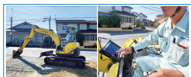
「土木現場の効率化」でカメラ搭載した ショベル(左)とタブレットでの確認状況(右)
