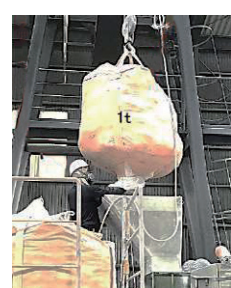
吊り物による作業は重労働で危険だった
